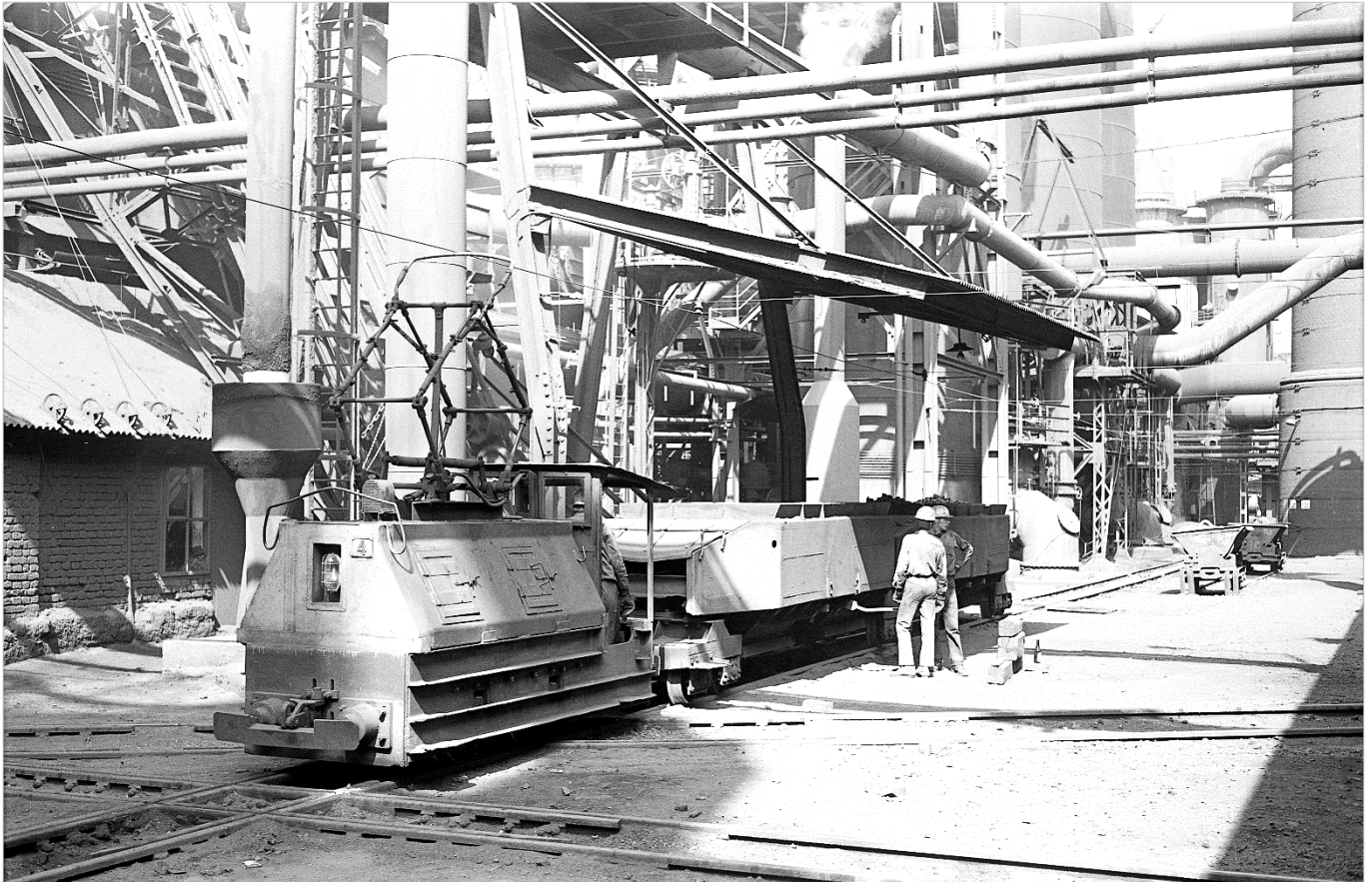
Die E-Lok 4 , erzeugt von den Österr. Siemens-Schuckert-Werken, Baujahr 1922 (mechanischer Teil wurde in Zeltweg hergestellt), beim Hochofen 3 mit zwei mit Erz beladenen Wagen, die über die Bodenklappen der Wagen entleert werden. Foto: Peter Schmied, 30. Mai 1970
