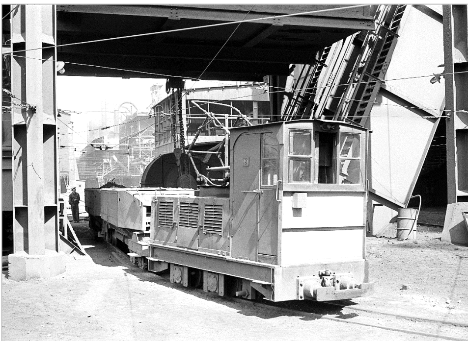
E-Lok 8 , Eigenbau der Elektrowerkstätte (Baujahr 1954) steht mit zwei Wagen zur Entleerung bereit. Im Hintergrund ist der Schrägaufzug zu sehen, wo mit Gichtkübeln das Erz in den Hochofen hinaufgezogen wurde.
