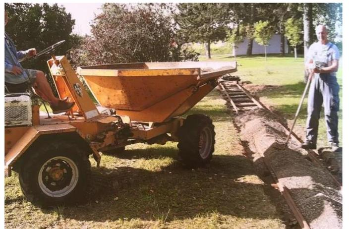
Etliche Tonnen Schotter wurden mithilfe eines Dumpers eingearbeitet
